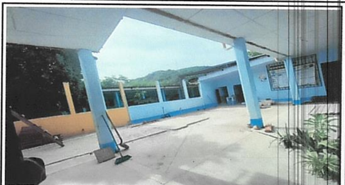
Foto 2: Desinstalación de Biblioteca de bambú
