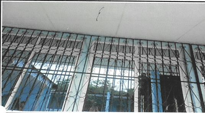
Foto 1: Fabricación e Instalación de ventanas PVC
