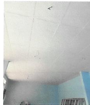
Foto 4: Sustitución e instalación de cielo falso
