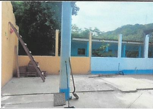
Foto 5: Reparación de muro perimetral de block
