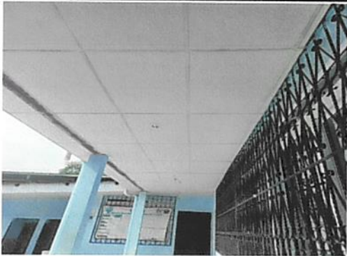
Foto 3: Pintura en muros, cocina, aula, dirección y baños exteriores e interiores
