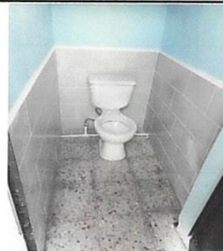
Foto 6: Sustitución de piso de granito
